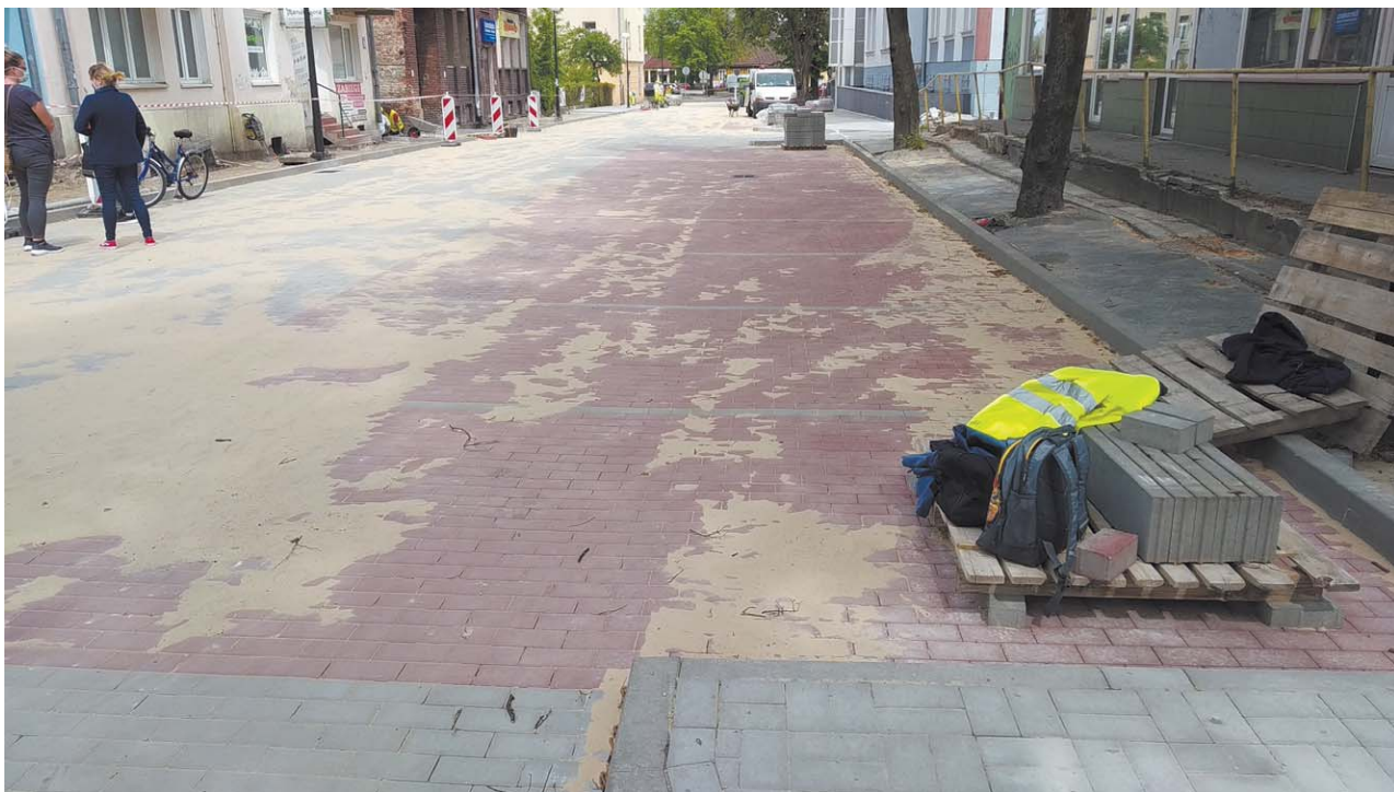
W kwietniu do pracy przystąpili drogowcy, których zadaniem było zajęcie się nawierzchnią i położenie jezdni – jak się okazało z kostki brukowej
