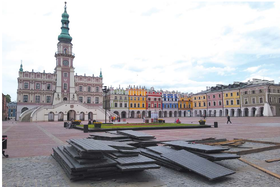
Restauratorzy układają już podesty pod ogródki
