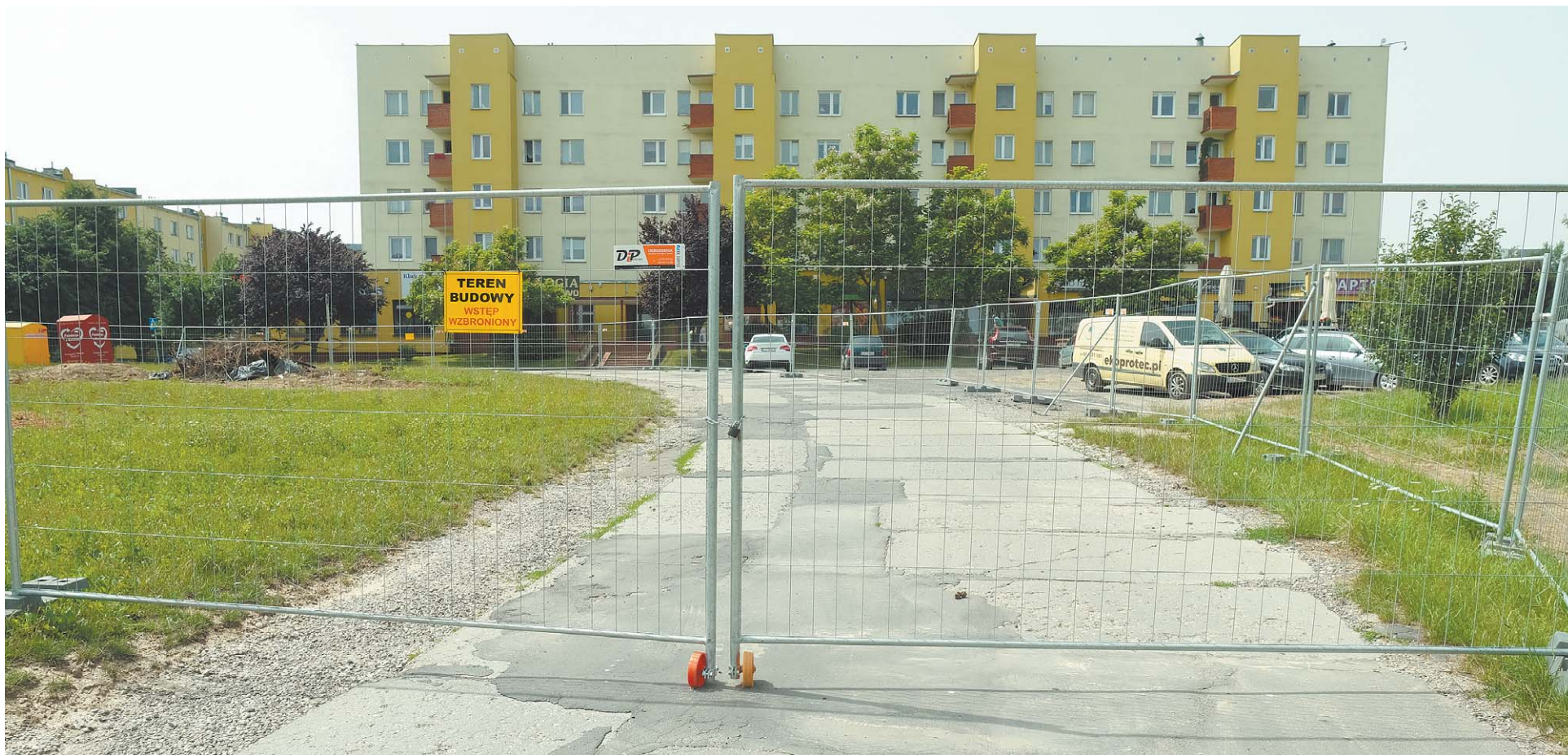
Przejazd po betonowych płytach nie był oficjalnie drogą
