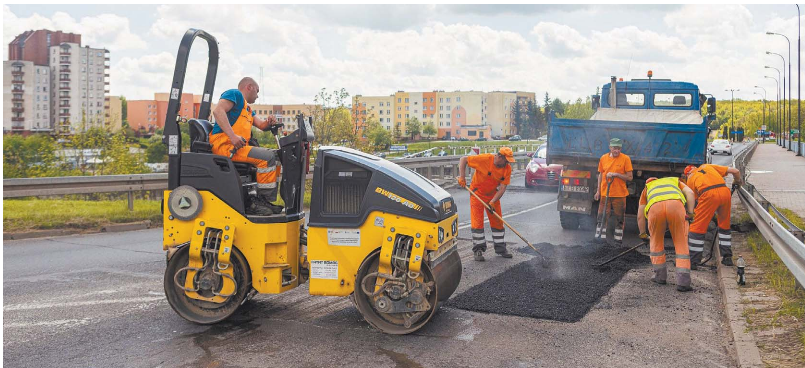
Prace prowadzone w ciągu dnia na ul. Filaretów powodowały wczoraj utrudnienia w ruchu
