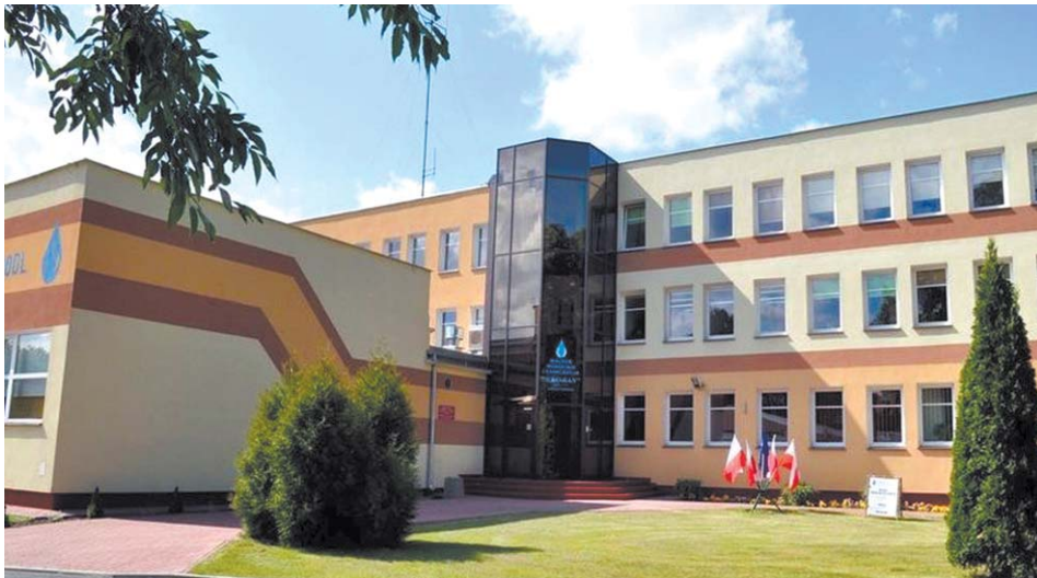
Spółka Wod-Kan prowadzi największą w jej historii przebudowę oczyszczalni ścieków i przepompowni. To przedsięwzięcie za 80 mln zł.
