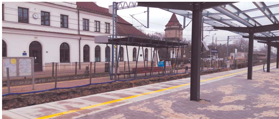
Na stacji budowany jest nowy peron wyspowy oraz przejście podziemne
