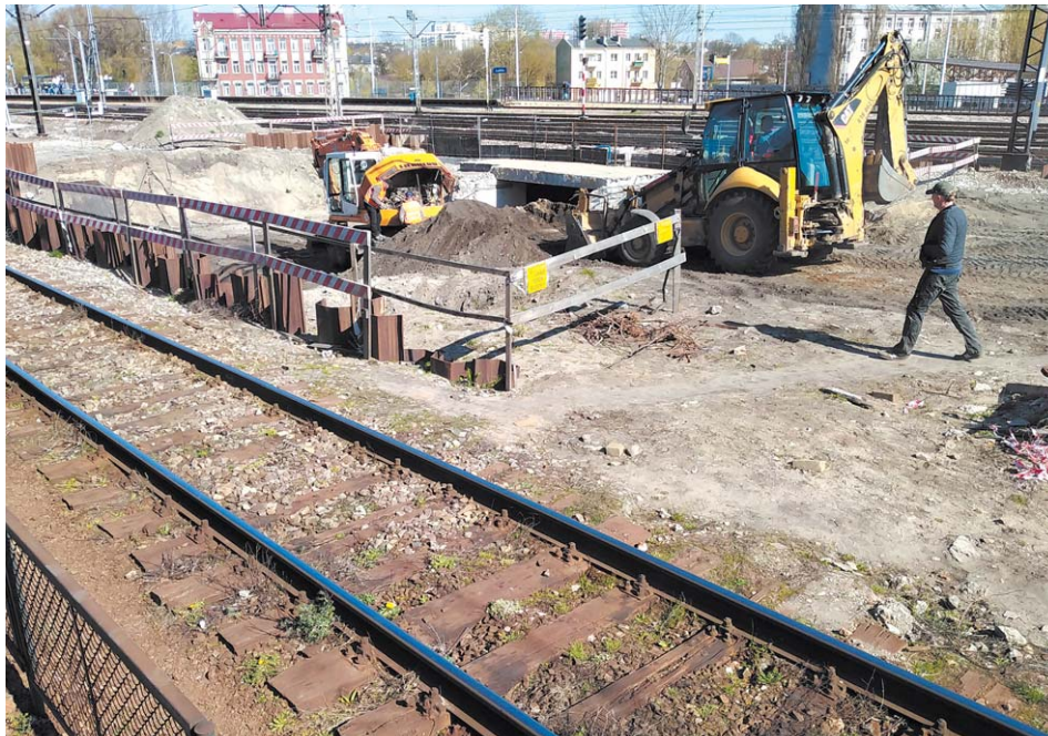
Wczorajsze roboty na stacji Lublin
