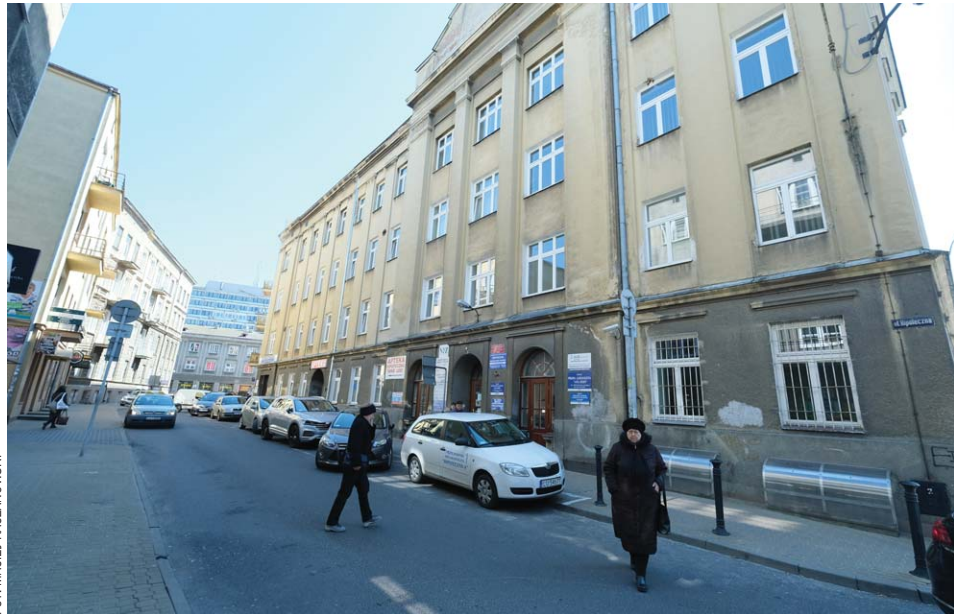
Czeka przy Hipotecznej 4 lokal w piwnicy budynku przychodni
