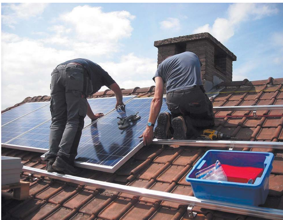
Panele fotowoltaiczne są niezawodne i zupełnie bezobsługowe. Szybko się je instaluje – doświadczony zespół montażu zajmuje około dwóch dni
