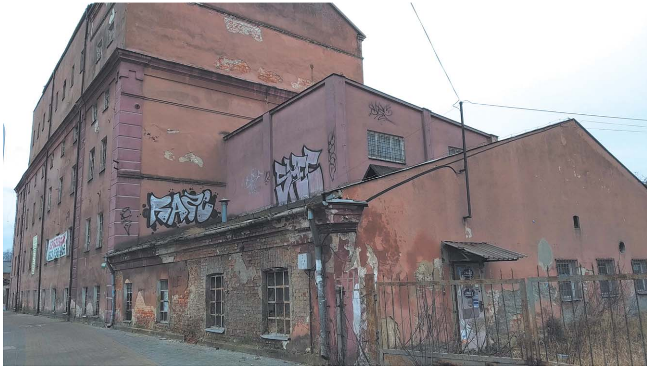
Opuszczony jeszcze w 2001 roku wielki budynek z powybijanymi szybami w oknach, łuszczącą się farbą i odpadającym tynkiem, wizytówką miasta nie jest
