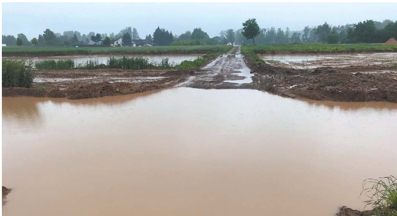
Na odcinku przyszłej S19 między Niedrzwicą Dużą a Kraśnikiem trwają prace budowlane. Po ostatnich intensywnych opadach deszczu, pojawiła się woda na budowanej drodze dojazdowej w Obrokach
