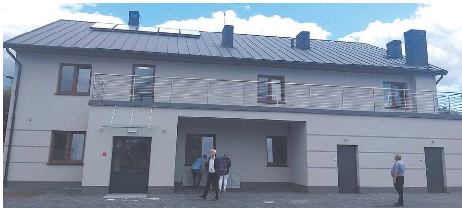
Budynek po dawnym hotelu został już wyremontowany
