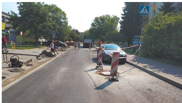
Trwają prace remontowe Al. Żołnierzy I Armii Wojska Polskiego
