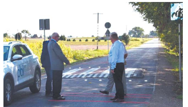
Droga w Śniadówce już z asfaltem
