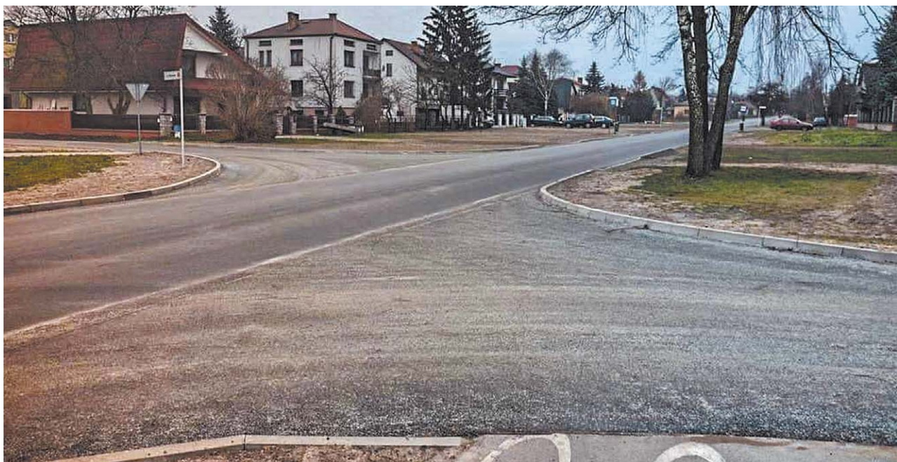
W grudniu urzędnicy chwalili się remontem 270 metrów ulicy Dalekiej. Jednak mieszkańcy dziwią się, że przy modernizacji zapomniano o chodnikach
