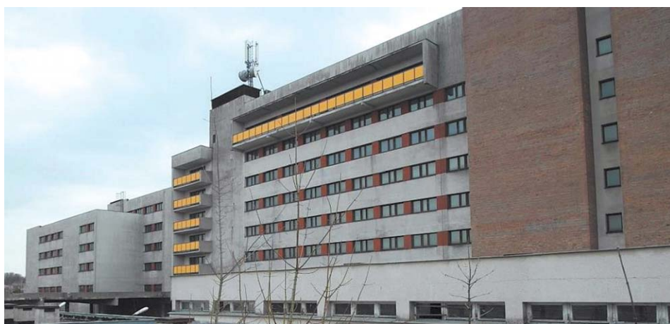
Nigdy nieukończone sanatorium Ministerstwa Spraw Wewnętrznych w Nałęczowie to sześciopiętrowy budynek o powierzchni ok. 17 tys. mkw
