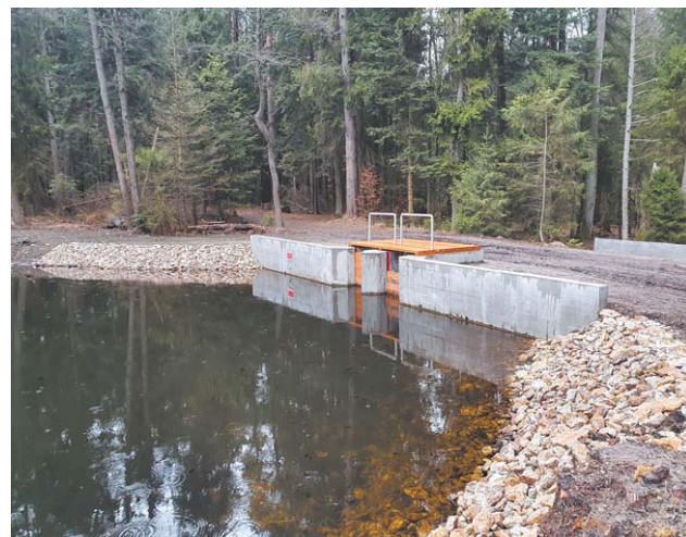
Urządzenie piętrzące wodę na tzw. Czarnym Stawie - po generalnym remoncie wykonanym w ubiegłym roku
