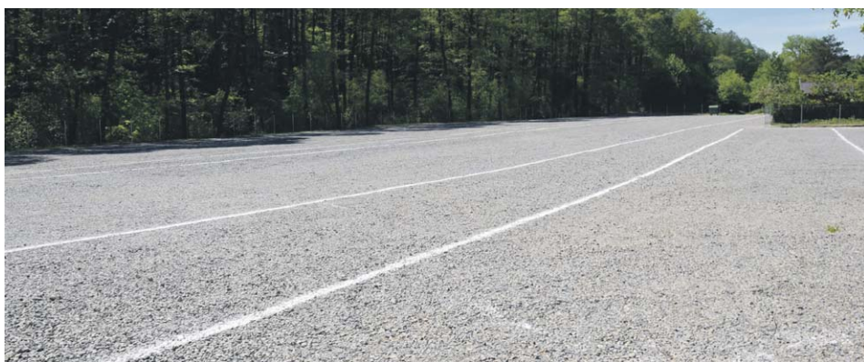
Władze w lutym podpisały umowę z przedsiębiorcą z Kazimierza Dolnego na utwardzenie terenu kruszywem kamiennym. Targowisko otwarto 21 maja
