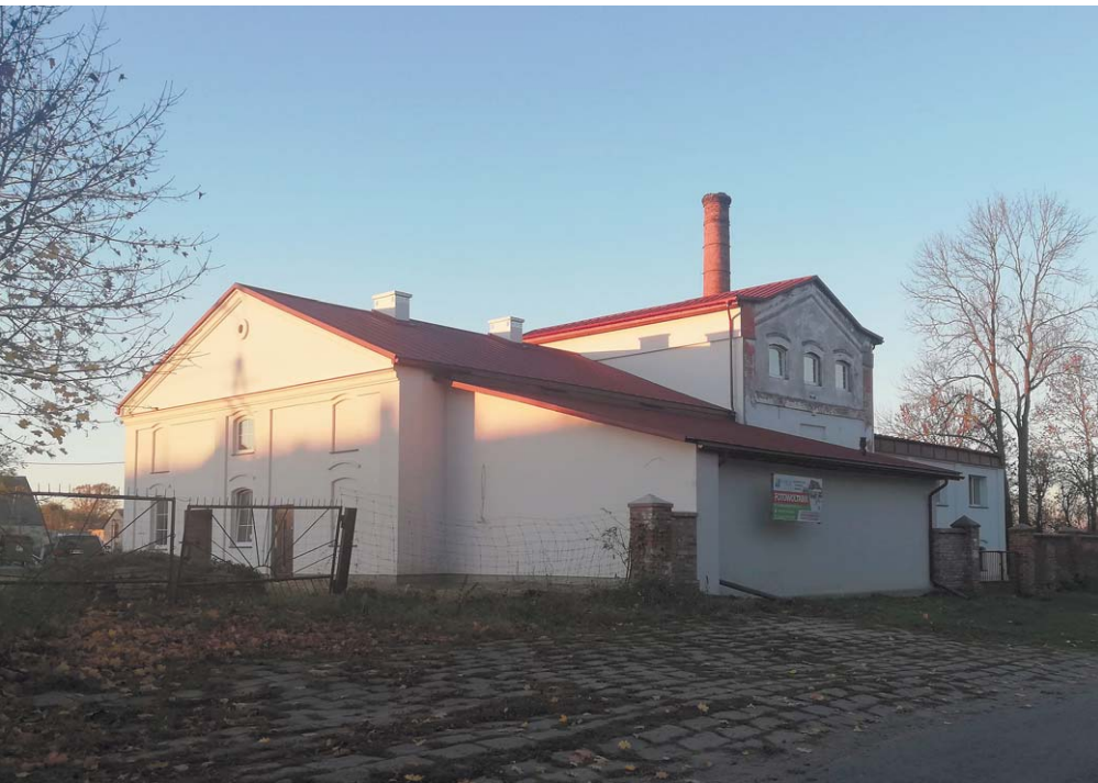
Remontowany budynek gorzelni z 1885 r., w którym w przyszłości znajdzie miejsce wystawa historyczna
