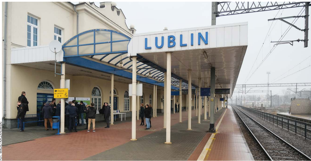
Jesienią możliwe stanie się przywrócenie ruchu pociągów z Lublina przez Nałęczów, Puławę i Dęblin do Warszawy
