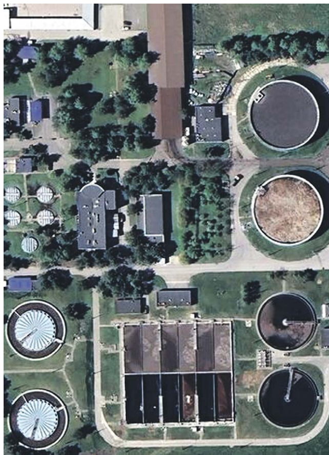
Oczyszczalnia ścieków w Chełmie
