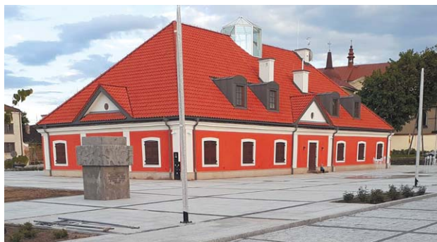
Budowa nowego placu i przebudowa zabytkowego ratusza dobiegły końca FOT. AGNIESZKA MAZUŚ
