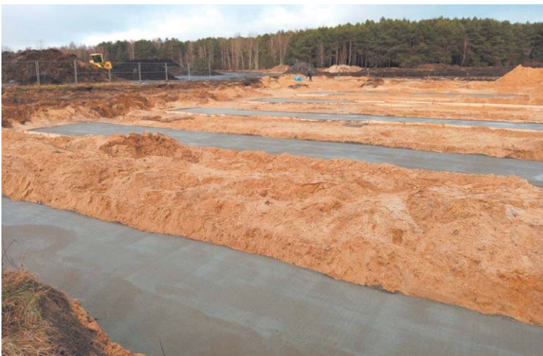
Roboty ziemne i betonowe pod bioreaktory kompostowni osadów ściekowych
