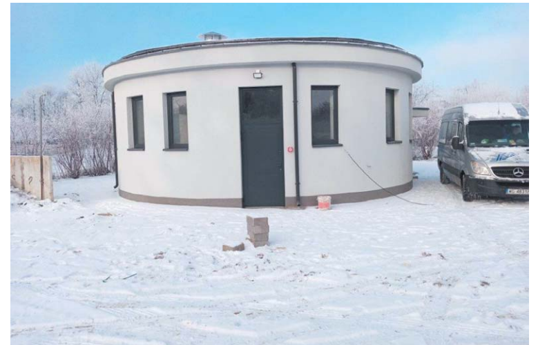
Pompownia ścieków Park Miejski
