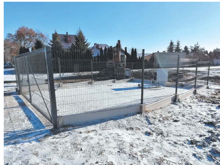
Pompownia ścieków ul. Kiernickich
