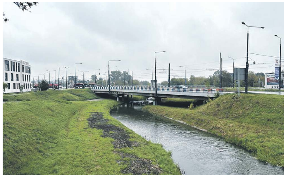
Remont dwóch mostów na Bystrzycy, budowanych kilkadziesiąt lat temu, to największe wyzwanie jakie czeka wykonawców robót
