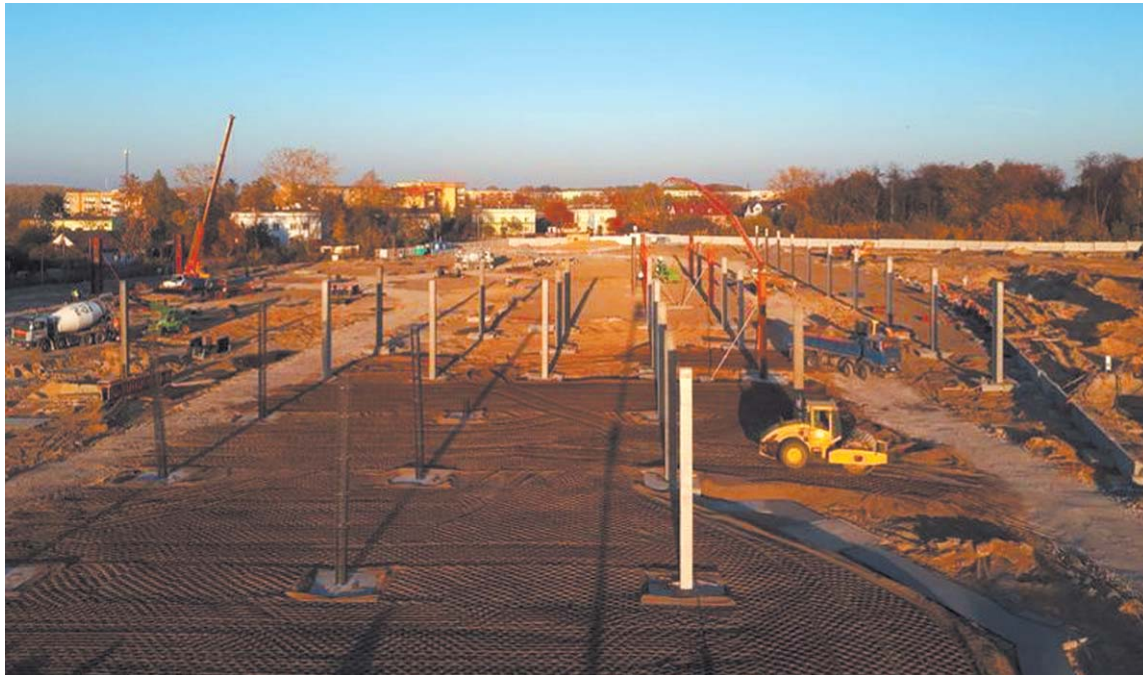
Prace przy budowie galerii stanęły rok temu
