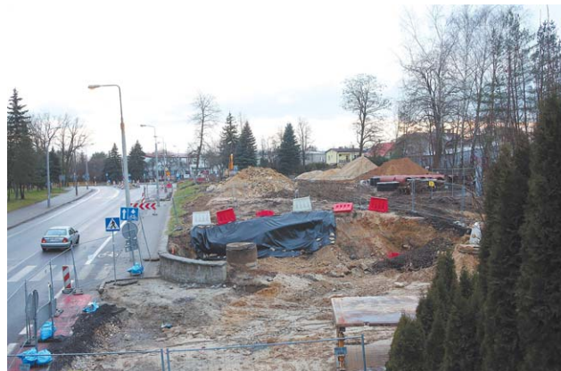
Prace budowlane w rejonie ul. Kolejowej w Świdniku
