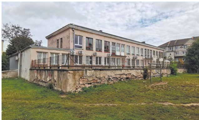
W tym miejscu ratusz zamierza wykonać 26-miejscowy parking i zlikwidować zdewastowany taras
