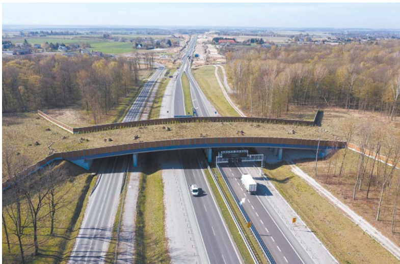
Przeście dla zwierząt na odcinku Lublin-Niedzwica
