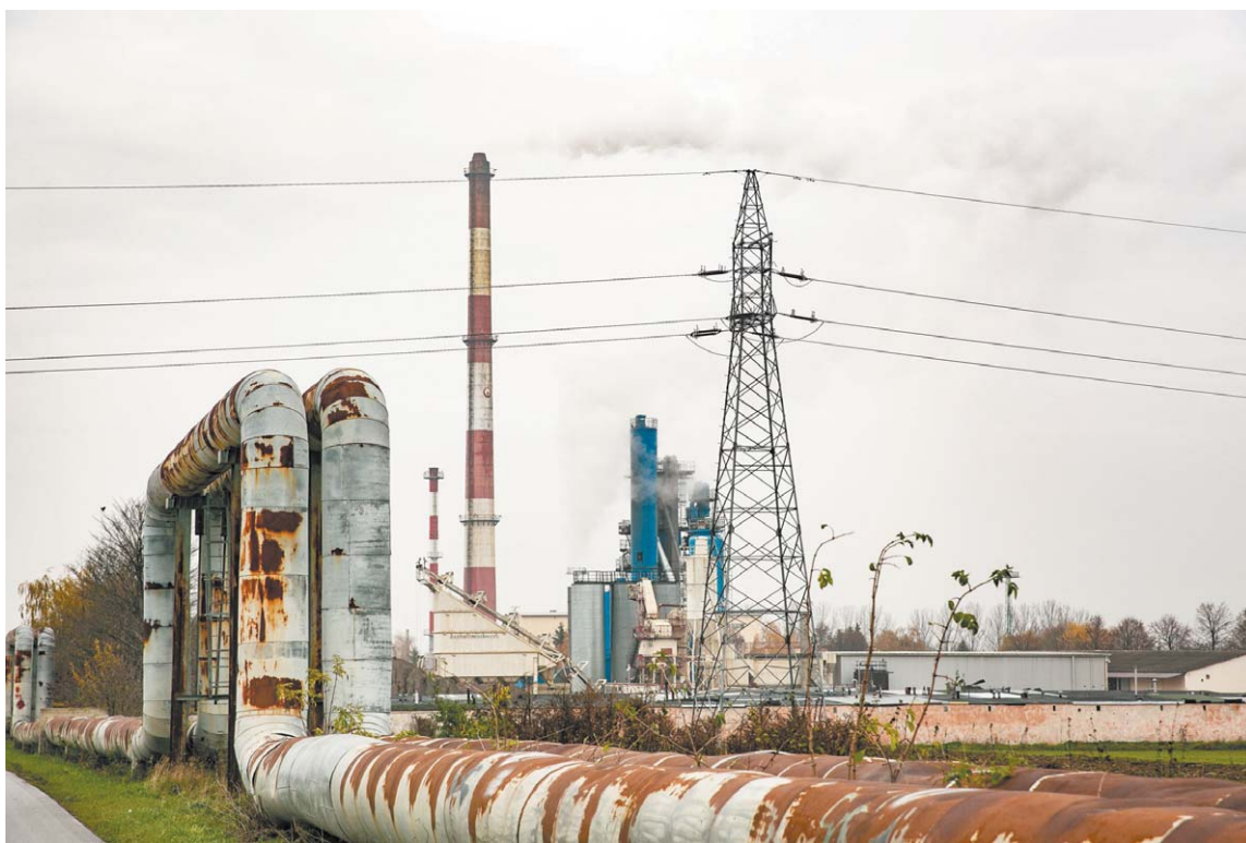
Spalarnia odpadów w obiegu zamkniętym ma powstać na terenie ciepłowni Szopinek
