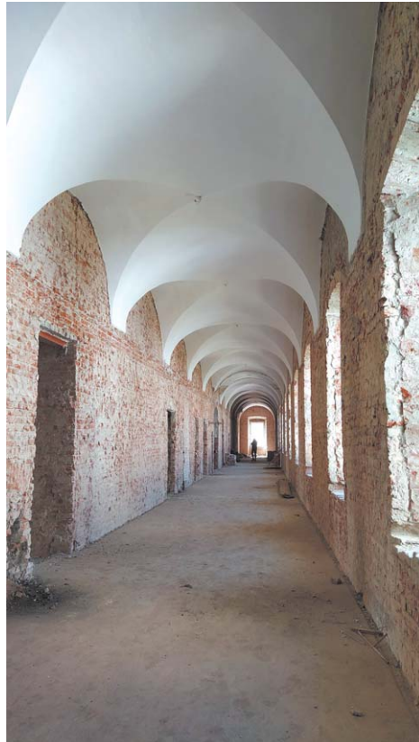
Jedno z remontowanych skrzydeł Akademii Zamojskiej
