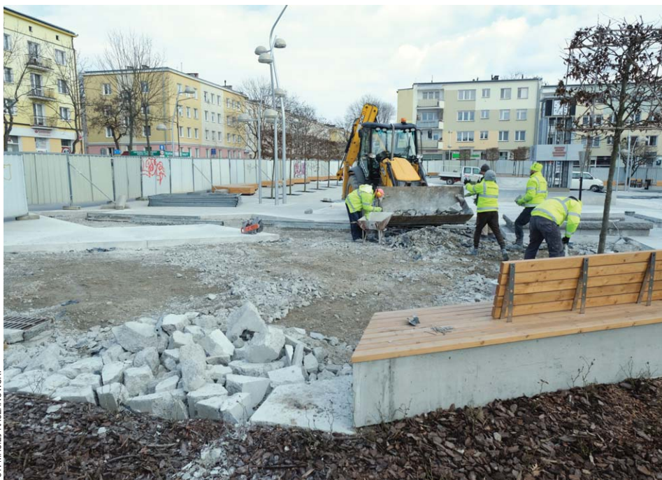
Na placu pojawił się ciężki sprzęt i robotnicy, którzy skuwają dopiero co położoną nawierzchnię
