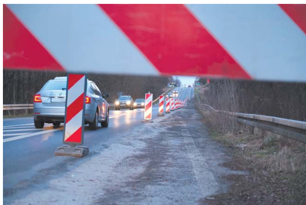
Ok. 6,7 mln zł trafi na remont dawnej drogi krajowej z Lublina w kierunku Warszawy (TOMA)
