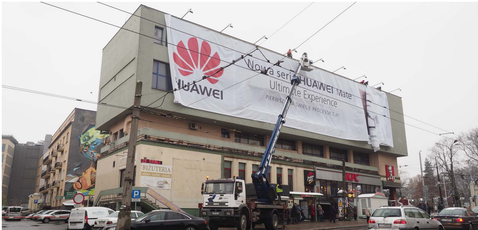
Reklama na fasadzie Astorii zawisa jesienią 2017 r., mimo zapewnień Ratusza, że na budynku już nie będzie reklam
