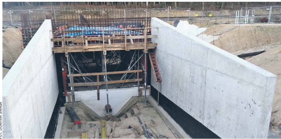
Rozgrzebaną i przerwana jest m.in. budowa nowego przystanku kolejowego Lublin Zachód na wysokości dzielnicy Czuby
