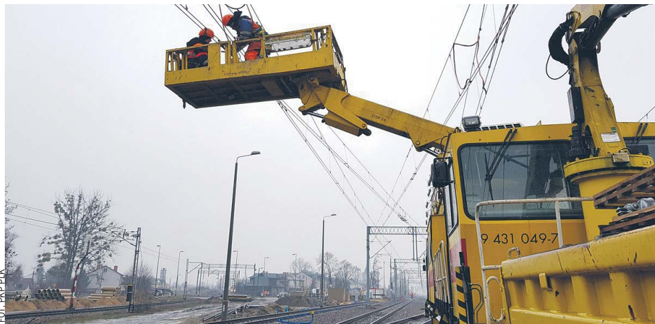
Za Dęblinem odnawiana linia wygląda inaczej, bo ma innego wykonawcę. Tory już leżą, a kilka dni temu wieszano tu trakcję
