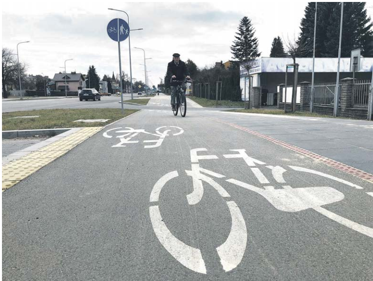
Niedawno gruntowny remont przeszła ulica Piłsudskiego w Zamościu. Wzdłuż niej ścieżek dla rowerzystów również nie mogło zabraknąć
