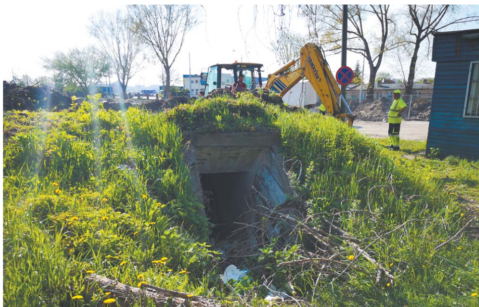
Szczelina przeciwlotnicza znajduje się w pobliżu torów kolejowych
