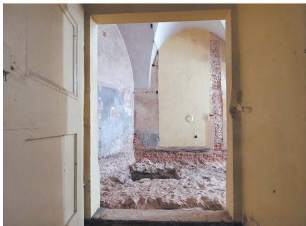
Pod podłogą zakrystii też odkryto fragmenty dawnej budowli FOT. LUBELSKI WOJEWÓDZKI KONSERWATOR ZABYTKÓW
