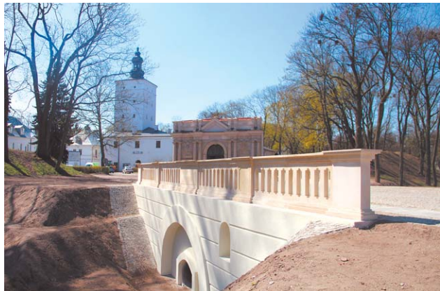
Park Radziwiłłowski. Zakończono już budowę bramy wjazdowej wraz z mostkiem
