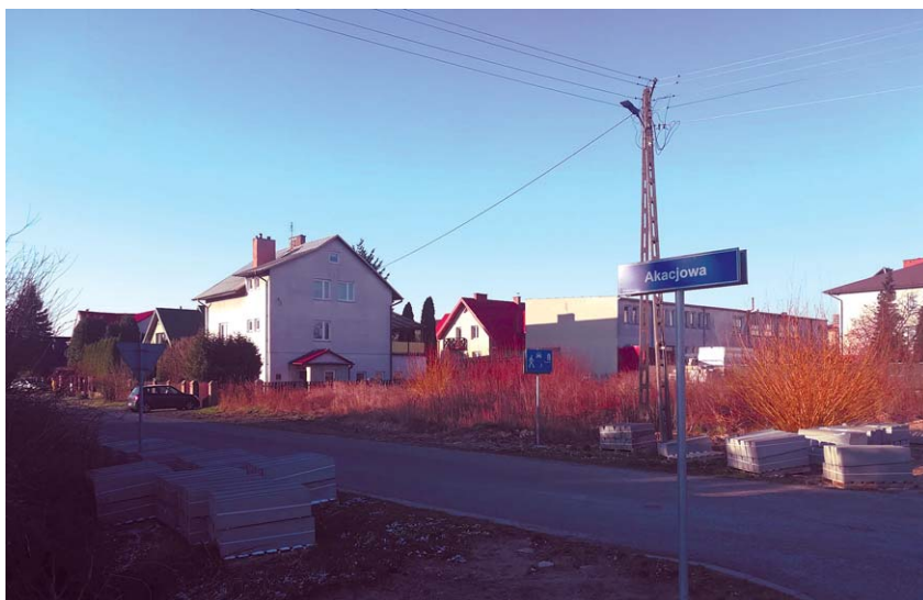
Ul. Akacjowa – jedna z dróg objętych planami przebudowy
