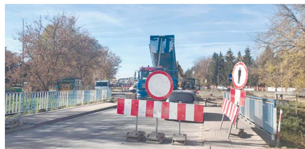
Mostem nad Łabuńką jeszcze przejechać się nie da, ale w poniedziałek ten odcinek ma być już otwarty
