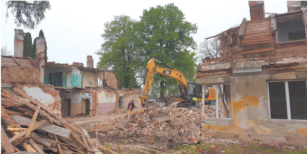
Wykonawca deklaruje, że z rozbiórką upora się do połowy czerwca
