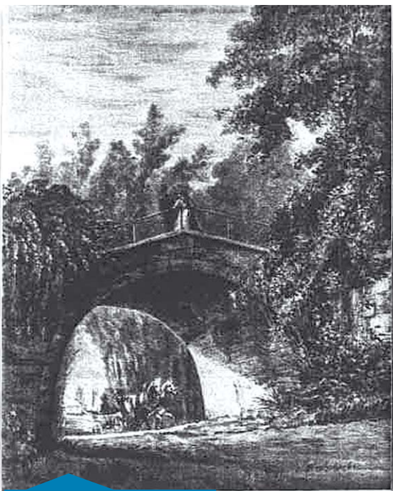
Most nad Głęboką Drogą
