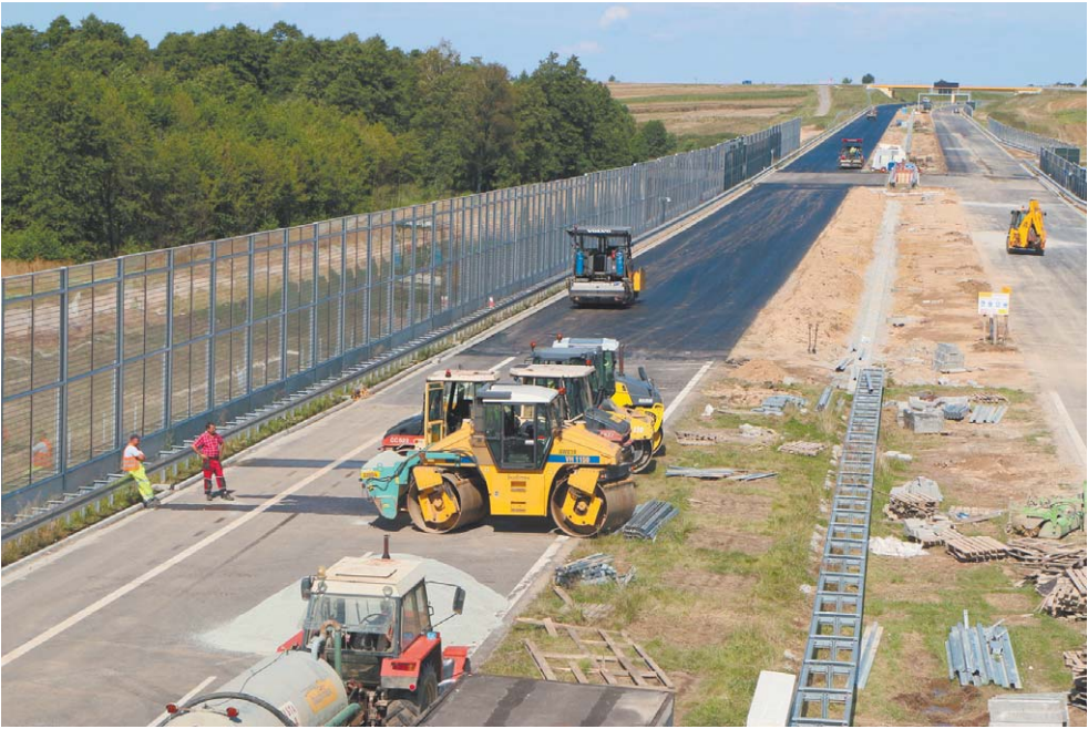
Sierpień 2014. Sieprawice. Naprawa nawierzchni S17, która zapadła się o kilkanaście centymetrów na długości 240 metrów
