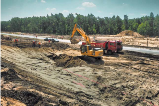
Sierpień 2014. Sieprawice. Naprawa nawierzchni S17, która zapadła się o kilkanaście centymetrów na długości 240 metrów
