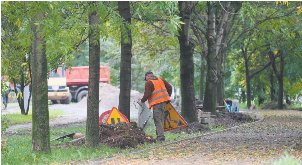
Za pieniądze z budżetu obywatelskiego budowana jest trasa rowerowa wzdłuż ul. Północnej
