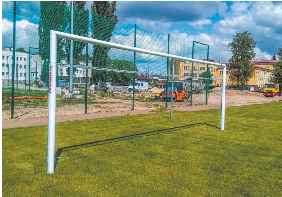
Dobiegają końca prace przy budowie parkingu oraz przy płycie boiska
