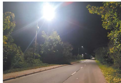
Modernizacja oświetlenia w miejscowości Wereszczyn
