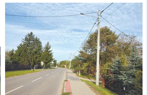
Modernizacja oświetlenia ulicznego w miejscowości Andrzejów
