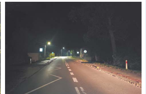
Modernizacja oświetlenia ulicznego w miejscowości Andrzejów
