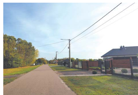
Modernizacja oświetlenia ulicznego w miejscowości Zabrodzie
