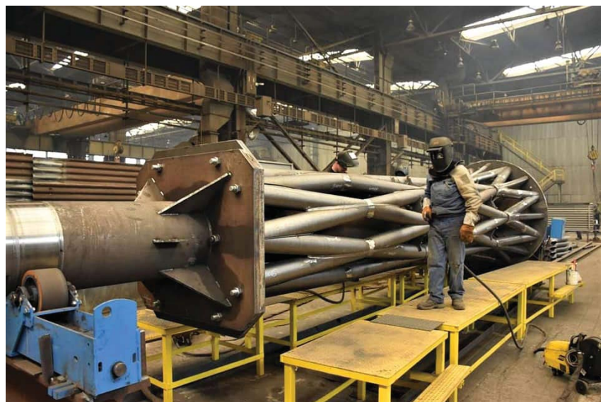
Na placu budowy korony słupów mają być łączone z ich trzonami
