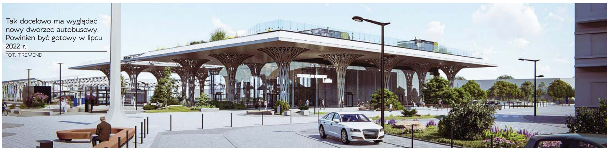
Największym i zarazem najcięższym elementem zadaszenia są korony słupów
