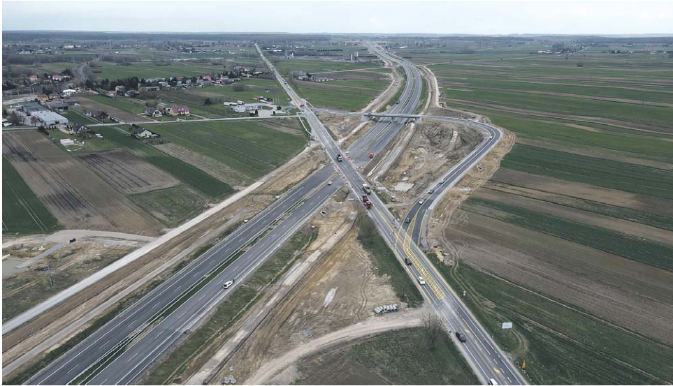
Jeszcze w tym miesiącu kierowcy pojadą ostatnim fragmentem S19 pomiędzy Niedrzwicą Dużą a Kraśnikiem. Na zdjęciu wiadukt w Wilkołazie
