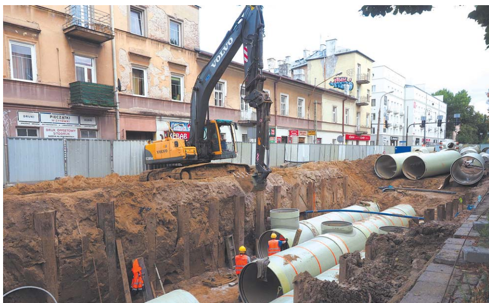
Na przebudowywanej ulicy wciąż trwa montaż kanalizacji burzowej
