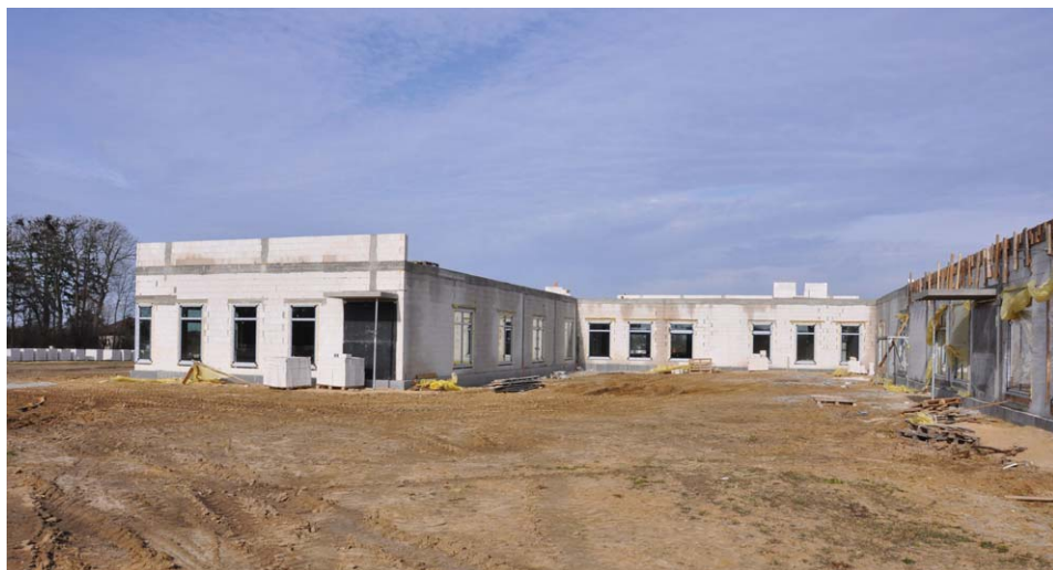
Tak wygląda plac budowy... na taki obiekt czekają mieszkańcy Świerszczowa
