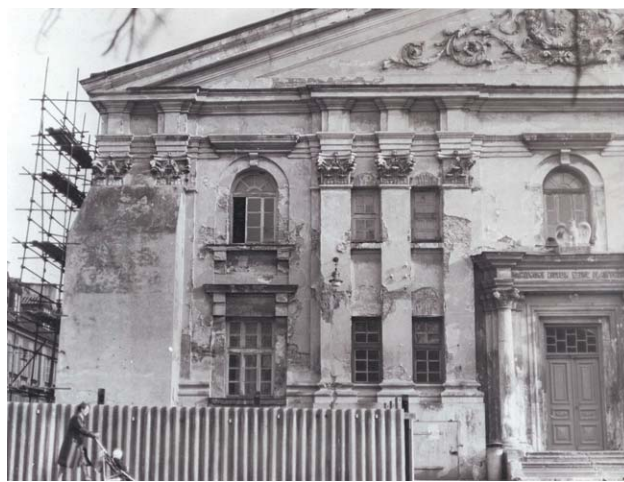
Lata 80. ubiegłego wieku. Elewacja zachodnia
