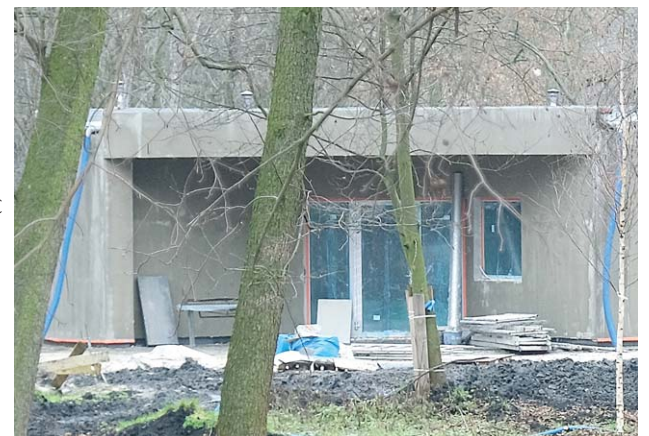
Wykańczany jest już budynek parkowej toalety
