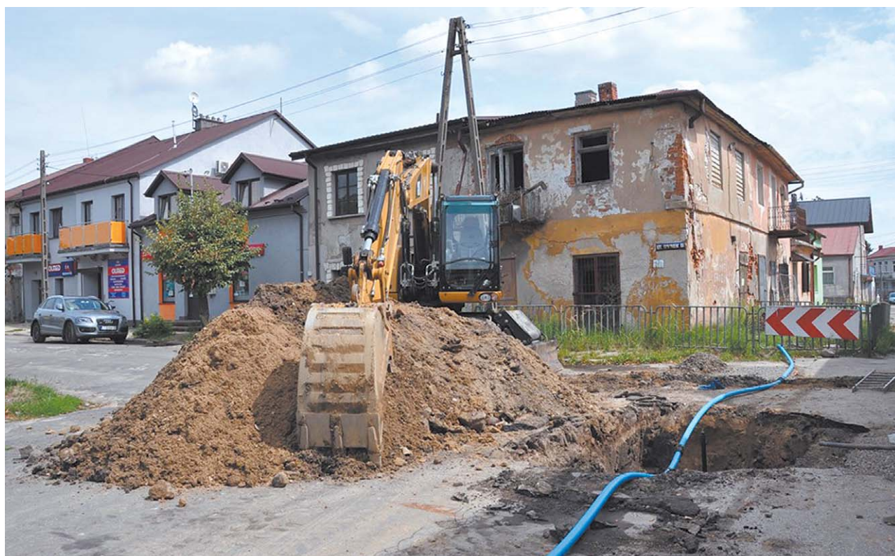
Do końca marca 2020 roku wykonawca przebuduje ponad kilometr sieci wodociągowej oraz ponad pół kilometra kanalizacji sanitarnej
