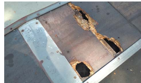
Zniszczone elementy skateparku powinny być naprawione jeszcze w sierpniu
