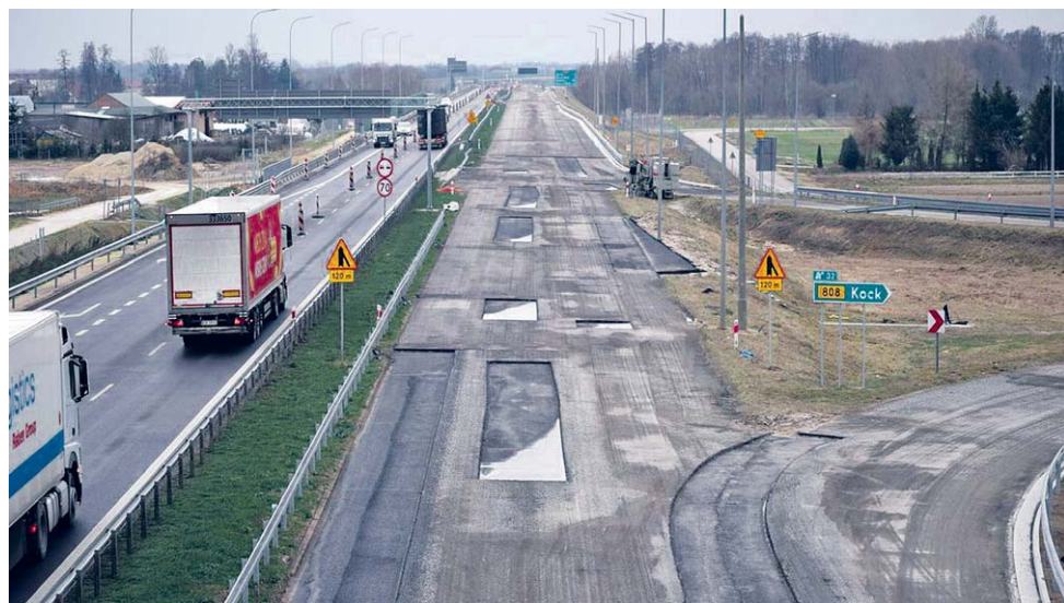
Budowa S19 – druga jezdnia obwodnicy
